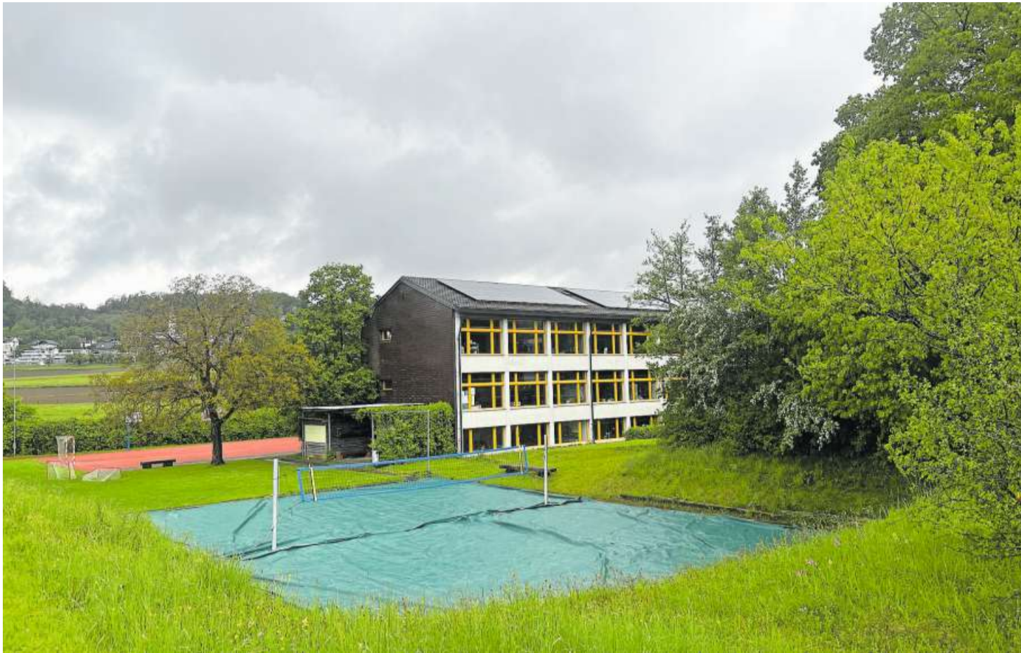
Angrenzend zum Schulhaus Aemmert soll der Neubau des Kindergartens entstehen.
